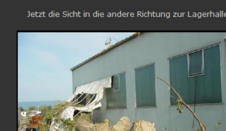
Hier erkennt man die Mächtigkeit des Wurzelstocks - rund vier mal drei Meter:
