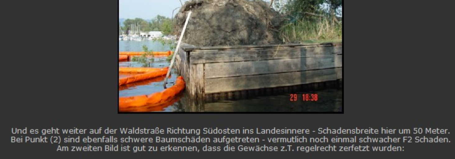
Auffällig ist daran, dass der Wurzelstock regelrecht aus der Erde heraus gedreht wurde - ein deutliches Zeichen für einen Tornado!
